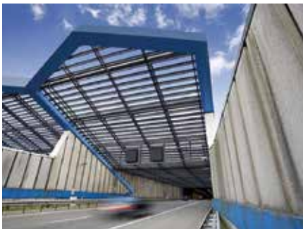
Schipholtunnel | Haarlemmermeer Vízvezetékek fagymentesítése 600 méter MAGNUM Trace Gutter Heat
