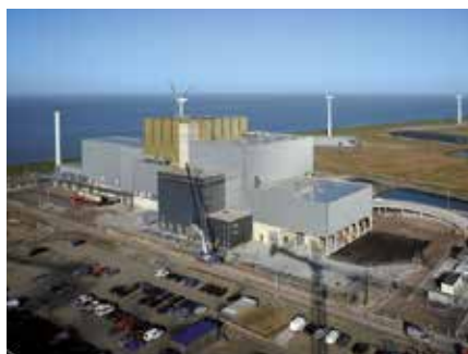
Reststoffenenergiecentrale | Harlingen Rámpák fűtése 680 m 2 MAGNUM Outdoor Cable
