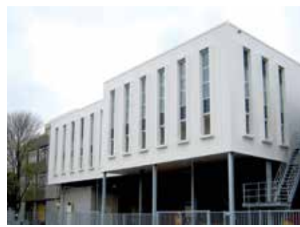
Friesland Campina | Ede Tető fagymentesítése 1275 m 2 MAGNUM Outdoor Cable
